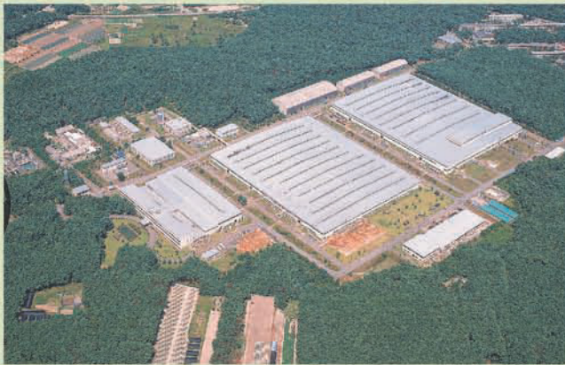
(株)日立産機システム中条事業所全景
